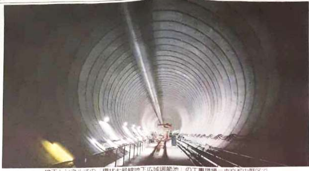
地下トンネル式の「環状七号線地下広域調節池」の工事現場＝東京都中野区で
