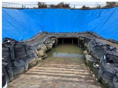
炭鉱の神祠から下ると坑口。潮の干満の影響受け、この時は満潮。坑口高さ1.6m、幅2.2m
